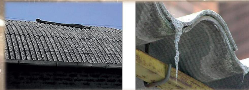
Fig.1-Un tetto di eternit non è pericoloso; quando inizia a sfaldarsi diventa pericoloso a causa delle fibre libere respirabili che entrano negli alveoli polmonari causando tumori, mesoteliomi, ecc.
